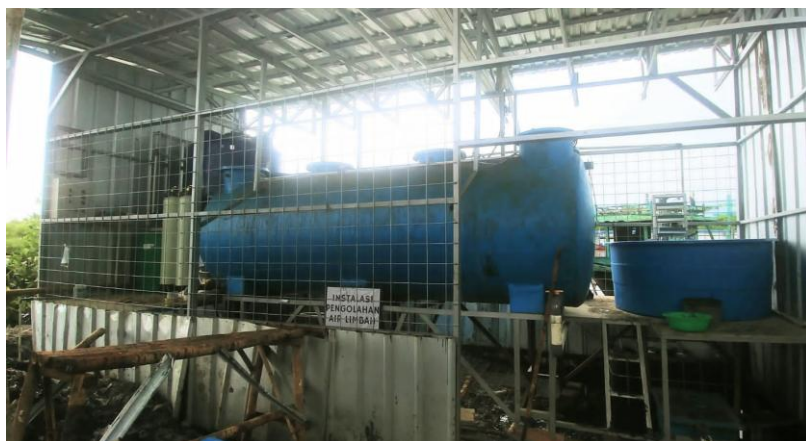
Gambar 3. Tampak Fisik IPAL di Muara Angke
